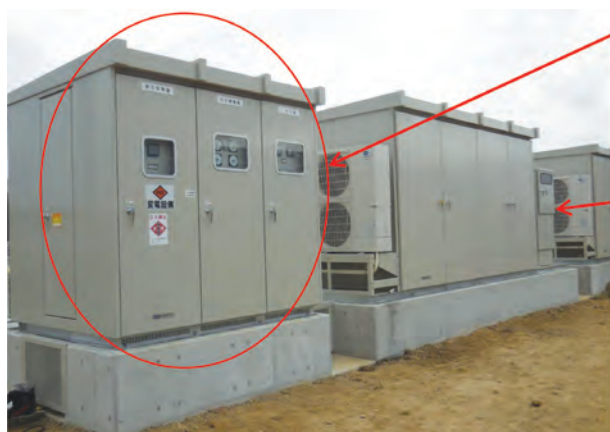
高圧連系・受配電盤の設置例
